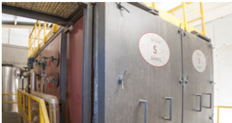
Caldera aqua-piro-tubular construida por Sugimat
