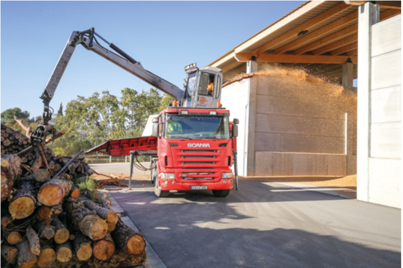
El Centro Logístico de Biomasa de la Comarca del Vallès Occidental, en Barcelona pondrá astilla en el mercado para alimentar las calderas de biomasa de la comarca.
