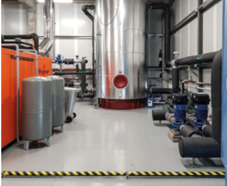
Sala de calderas con dos equipos Heizomat THK-AK de 500 kW, depósito de inercia de 20.000 l y sistema de bombeo
