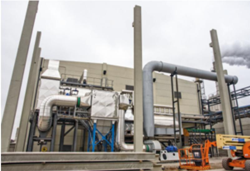
Instalación de la tercera unidad de generación de vapor, compuesta por una cámara torsional y una caldera de biomasa
