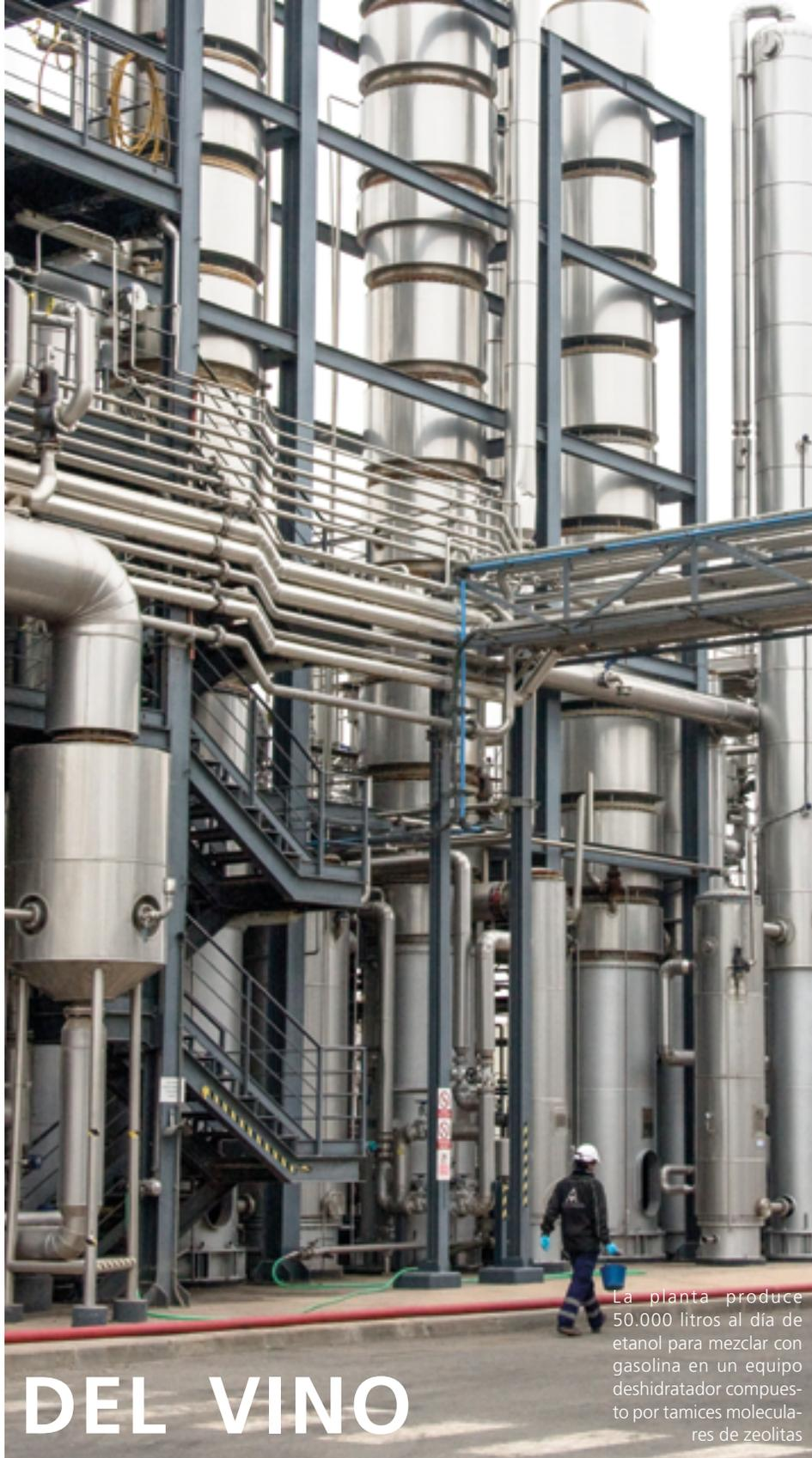
La planta produce 50.000 litros al día de etanol para mezclar con gasolina en un equipo deshidratador compuesto por tamices moleculares de zeolitas
