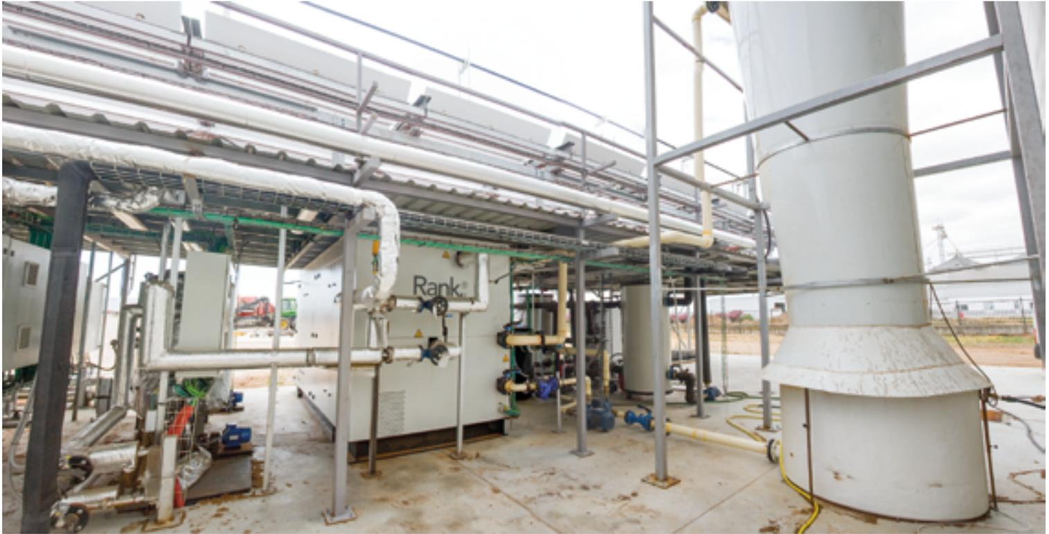
El proceso de microtrigeneración produce alrededor de 400 kW de energía térmica, 56 kW de electricidad y 35 kW de frío gracias a un proceso de hibridación entre biomasa y energía solar.
