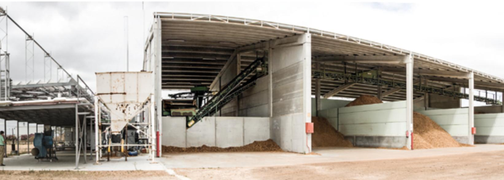
La planta piloto de microgeneración se ha diseñado como un sistema compacto, modular, escalable y portátil que hibrida energía solar y bioenergía procedente de biomásas residuales agrícolas o forestales.
