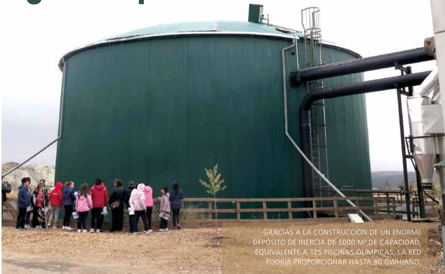
GRACIAS A LA CONSTRUCCIÓN DE UN ENORME DEPÓSITO DE INERCIA DE 5000 M<sup>3</sup> DE CAPACIDAD, EQUIVALENTE A 125 PISCINAS OLÍMPICAS, LA RED PODRÍA PROPORCIONAR HASTA 80 GWH/AÑO.
