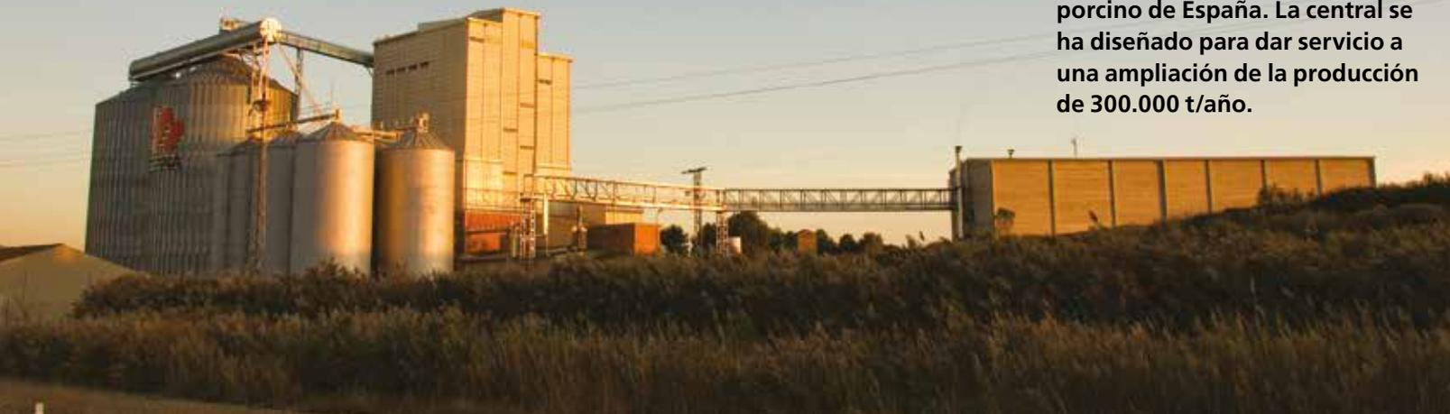
**EN LA FÁBRICA DE TORRES DE BARBUÉS**, Imartec ha instalado una central de biomasa para generar hasta 4 t/h de vapor. En breve, la producción de pienso se triplicará hasta alcanzar las 300.000 t/año, por lo que la caldera se ha dimensionado para dar servicio a las necesidades futuras.
